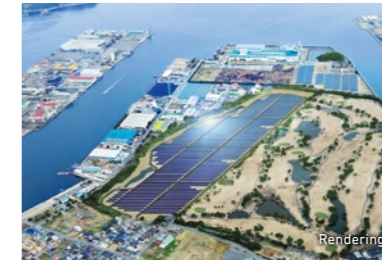
Solar power plant (Kagawa)
