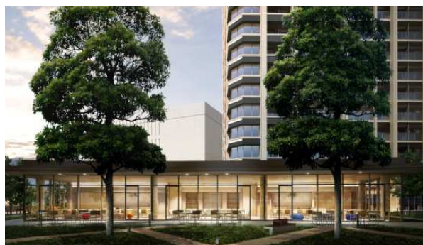
コミュニティハウス 2 つのパーティールームとカルチャールームをご用意。可動間仕切りをオープンにすれば、3 つの空間の一体利用も可能です。
