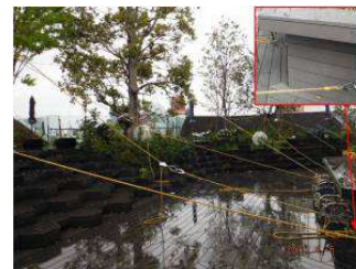
■強風時の養生ロープ(親綱)掛け
