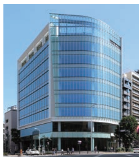
スプライン青山東急ビル 港区
