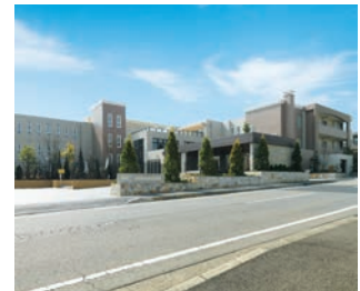
8 グランクレール青葉台
