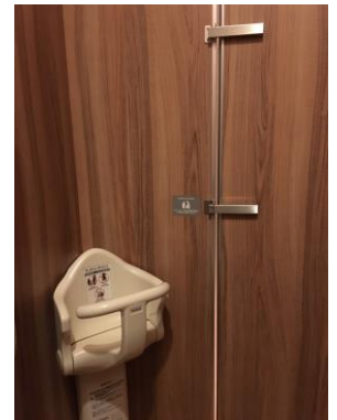
全施設共通 鍵を追加で設置
