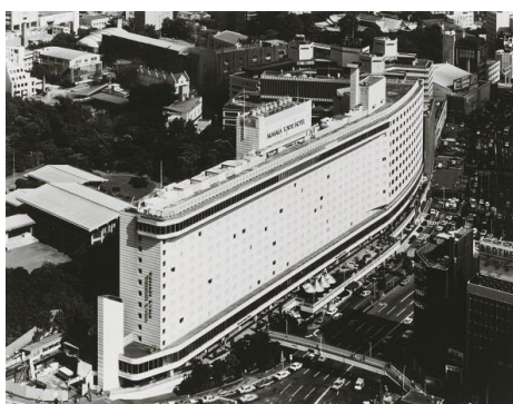
開業時「東急プラザ赤坂」赤坂上空から
