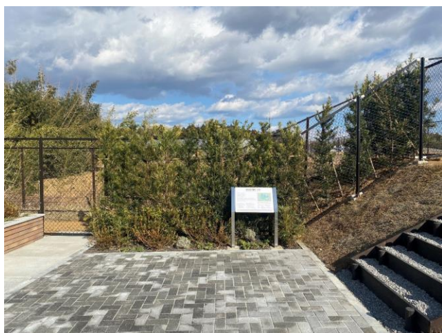
リエネ行方太陽光発電所 交流スペース
