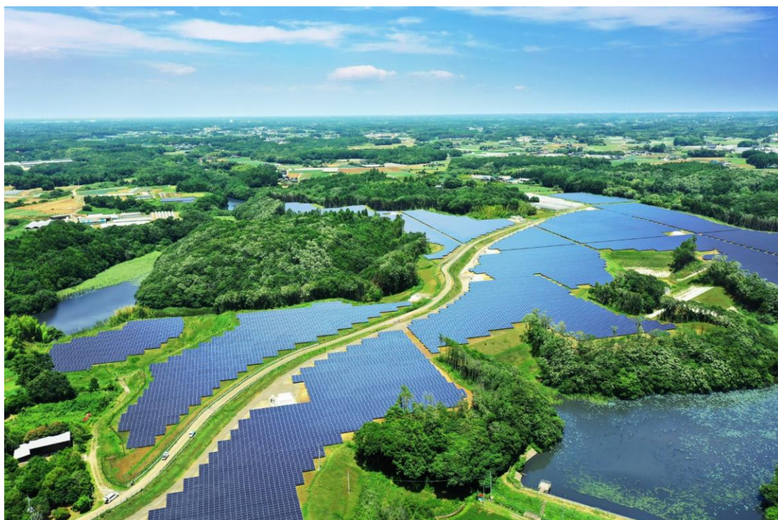
リエネ行方太陽光発電所
