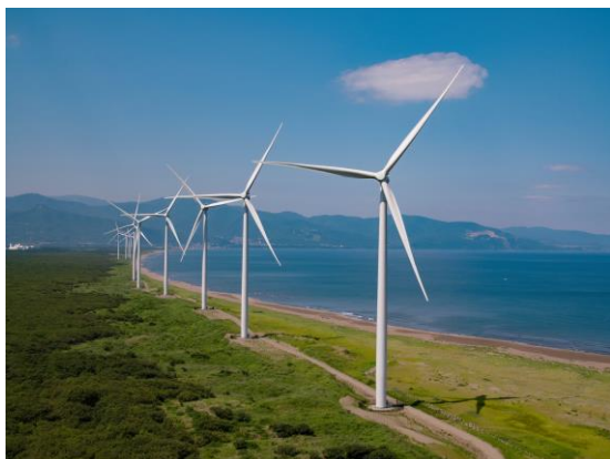
リエネ銭函風力発電所（北海道小樽市）
