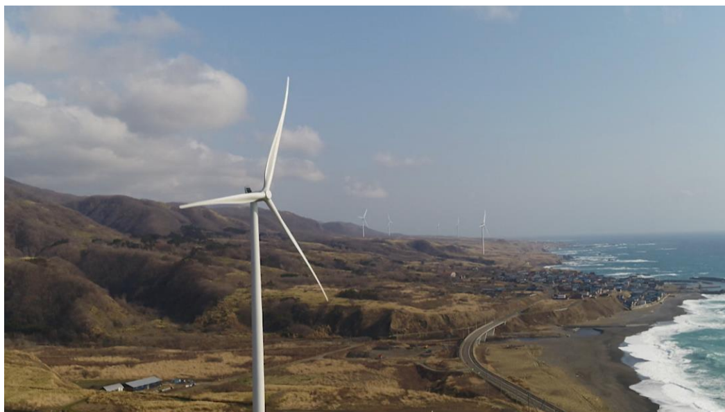
リエネ松前風力発電所
