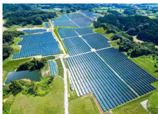
リエネ長南太陽光発電所 （千葉県長南町）
