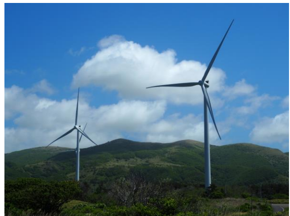
リエネ松前風力発電所（北海道松前町）
