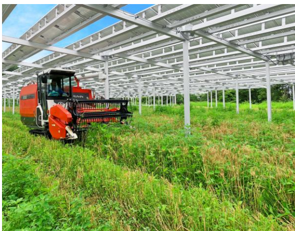
一関市鈴ヶ沢太陽光発電所（岩手県一関市）
