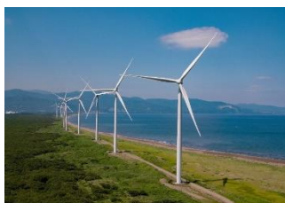
リエネ銭函風力発電所 （北海道小樽市）
