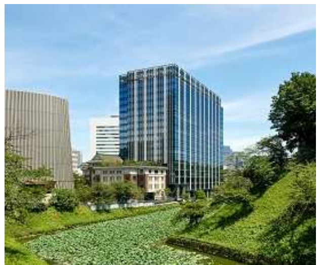
「九段会館テラス」外観（田安門より）
