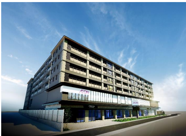
建物外観（西側）
