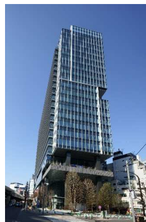
調査対象オフィスビルの一例 (渋谷ソラスタ)
