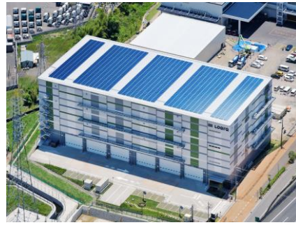
リエネ LOGI'Q 枚方太陽光発電所
