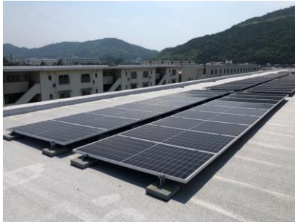
旧雇用促進住宅屋根上
