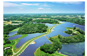
リエネ行方太陽光発電所
