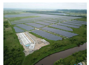
すずらん釧路町太陽光発電所
