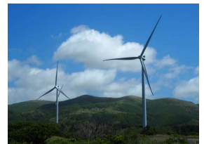
リエネ松前風力発電所
