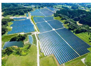
リエネ長南太陽光発電所
