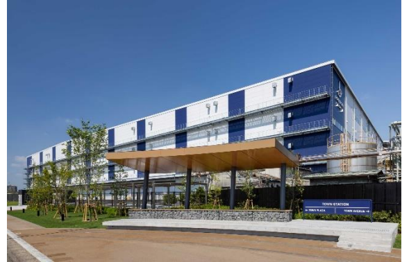
【Town Station】 線路をイメージした緑道とベンチ
