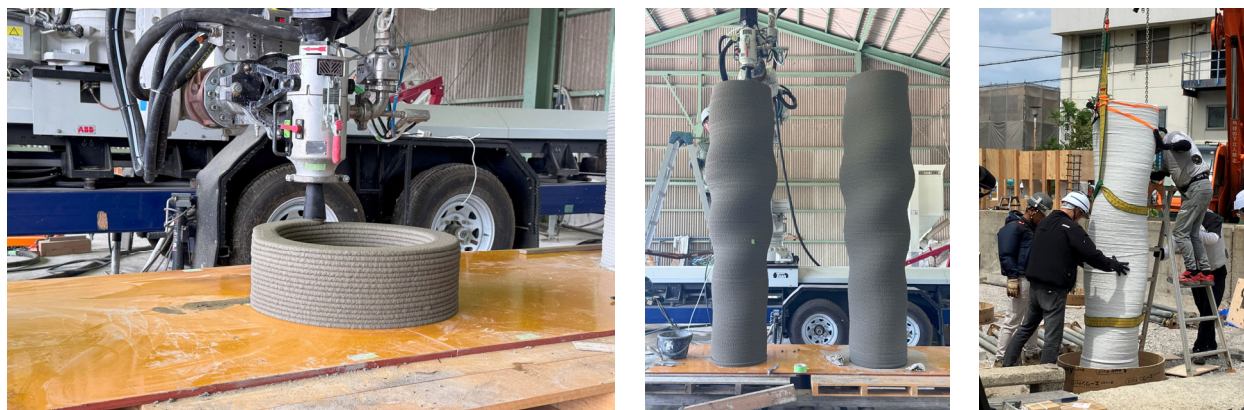
左・中央：3D プリンターで柱を出力する様子 右：3D プリント製の柱を設置する様子
