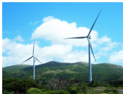
リエネ松前風力発電所
