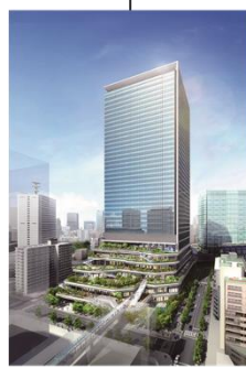
オフィスタワー (A 街区)
