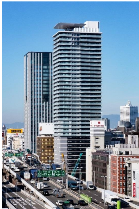
ブルンズタワー御堂筋本町外観
