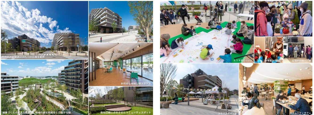
横浜グリーンバトンプロジェクト 左) 建物 右) エリアマネジメント活動
