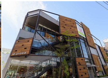
レールと枕木を取り入れた 特徴的な外観
