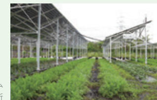
リネソーラーファーム 東松山太陽光発電所
