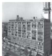
東急スカイライン
