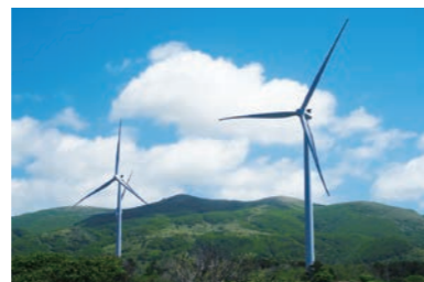
リエネ松前風力発電所
