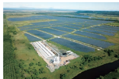
すずらん釧路町太陽光発電所
