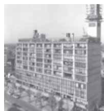
東急スカイライン
